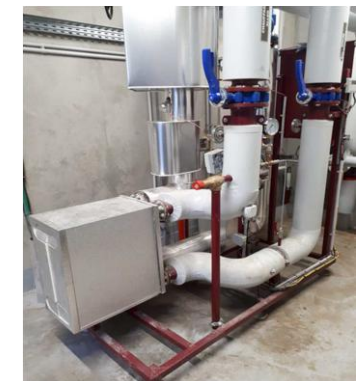
Sous-stations (point de livraison à l'abonné)
